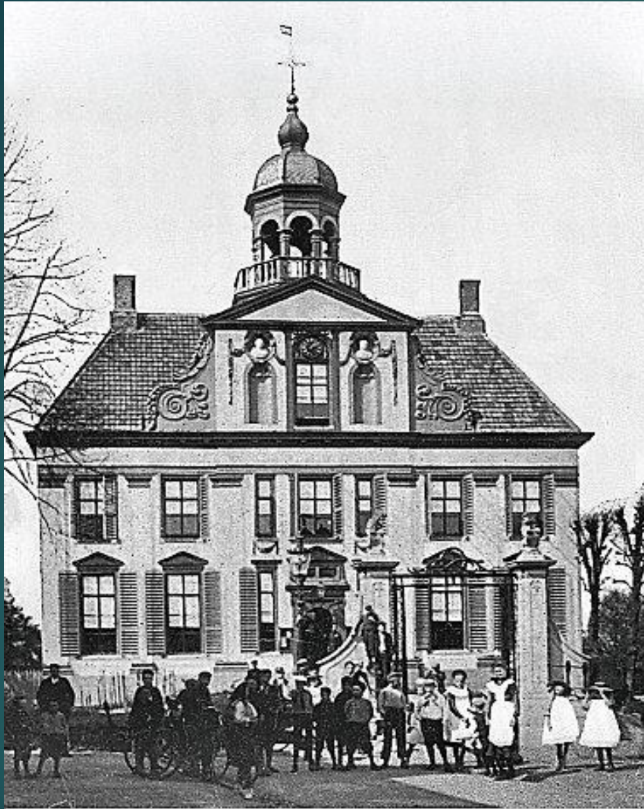
Heerenveen, Crackstate, Gerechtsgebouw, omstreeks 1909
